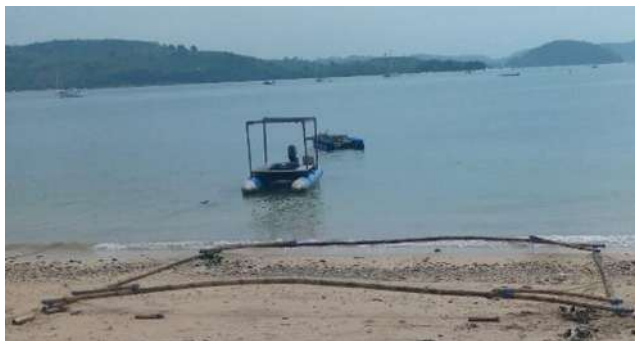
Gambar 2. Pembuatan konstruksi rakit apung.
