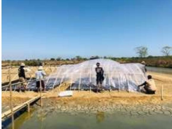
**Gambar 5. Pembuatan *Greenhose Salt Tunnel* (GST) dengan alas geomembran**
