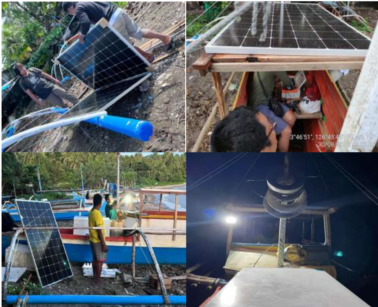
Gambar 5. Pemasangan panel solar cell diatas perahu pamboat Mitra dan uji coba pendingin Dan penyalaaan lampu berenergi solar cell
